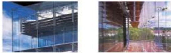
شكل 15. يوضح واجهة ذات الكاسرات داخل التجويف المزدوج
