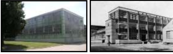
شكل 8. يوضح مصنع Steiff، 1910 والزوايا المزججة من المبنى الرئيسي للمصنع توضح الغلاف المزدوج للواجهة [15].
