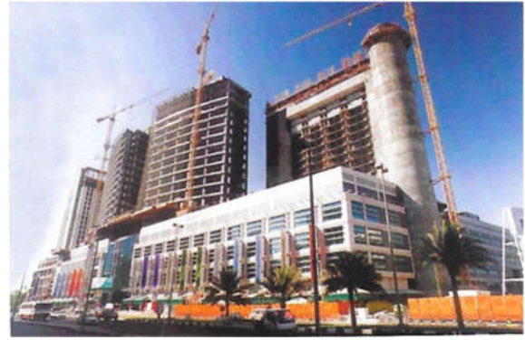
الشكل (10): يوضح مركز ابو ظبي التجاري قيد الانشاء [3]
