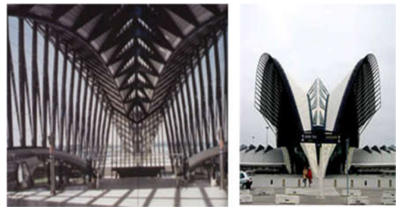
الشكل 1: يوضح مشروع (محطة ليون , فرنسا , للمعماري سانتياغو كالاترافا , 1994) (المماثلة مع الطير في حركة طيرانه)
