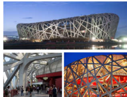
الشكل 7: يوضح مشروع (National Olympic Stadium, Beijing) لمصممه المعماري هرتسوغ دي ومورون , حيث الفكرة التصميمية لهيكل من الصلب مستوحى من عش الطيور لتحقيق مبدأ الاحتواء و توزيع القوى بالتساوي و بما يتلاءم مع الوظيفة من حيث الانسيابية الشكلية 2003-
