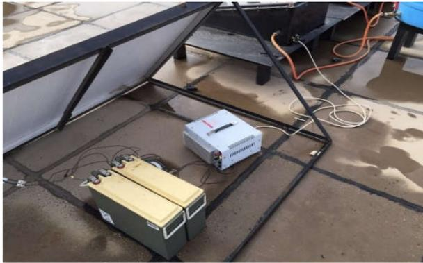
شكل 8: تثبيت السلك الحراري ومنظومة الطاقة الشمسية
