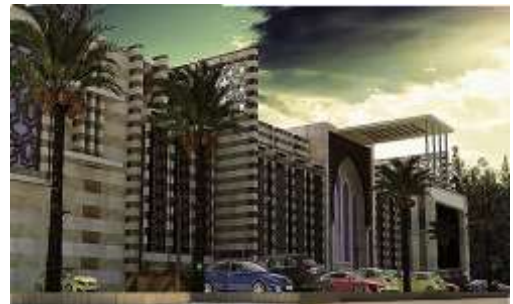
الشكل 23: مشروع إعادة إعمار مبنى السرايا
