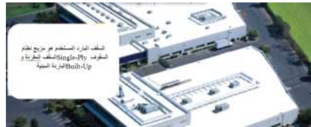
الشكل 16: السقف البارد المنفذ على مبنى نوركال Nor-Cal الاداري في مدينة فيرمونت، كاليفورنيا
