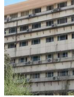
ح- تشوية واجهة المبنى الأساسي من خلال وضع جسور حديدية للمكيفات
