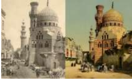
الشكل (5) منذنة خاير بك اثناء وبعد عملية إعادة البناء [18]
