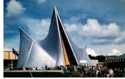
شكل2: يبين مبنى Philips Pavilion, Le Corbusier [14]
