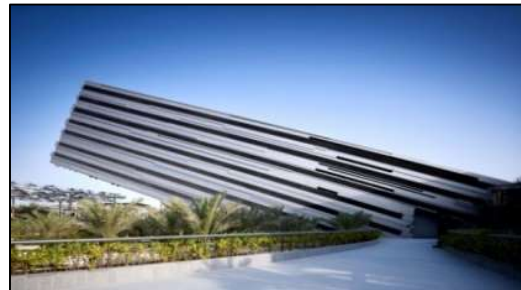
الشكل 6 : الواجهة الجانبية للمبنى
