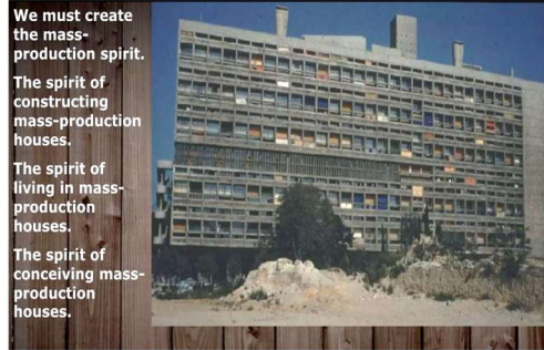
شكل 2 : مبنى الوحدة السكنية في مرسيليا للمعمار لو كوربوزيه 1950 كنموذج للإنتاج الكمي في العمارة
