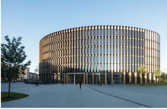
شكل 20: واجهة المبنى مع الألواح الكهروضوئية المتكاملة وظلال الشمس
