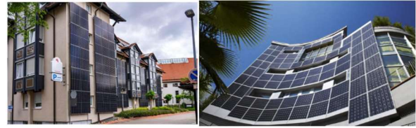
شكل 1: استخدام الخلايا الشمسية السوداء او الزرقاء كواجهات للأبنية مما اكسبها مظهراً غير مقبول
