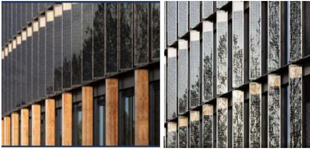
شكل 21: منظر لنظام الكهروضوئية المركب على الواجهة
