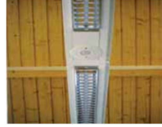
شكل 20: الحساس المستخدم بنظام الإضاءة لقياس مستويات الإضاءة الطبيعية و مزود بجهاز استقبال بالأشعة تحت الحمراء [22]
