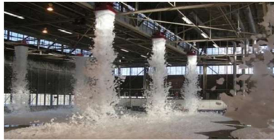
شكل 8: نظام الرغوة الأوتوماتيكي
