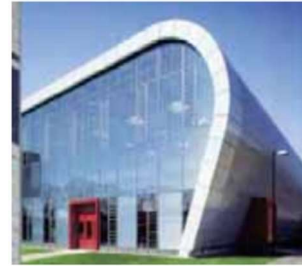
شكل 21 : يوضح الواجهة الزجاجية بخلايا (PV)
