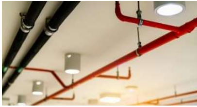
شكل7: نظام الرش الأوتوماتيكي[37]
