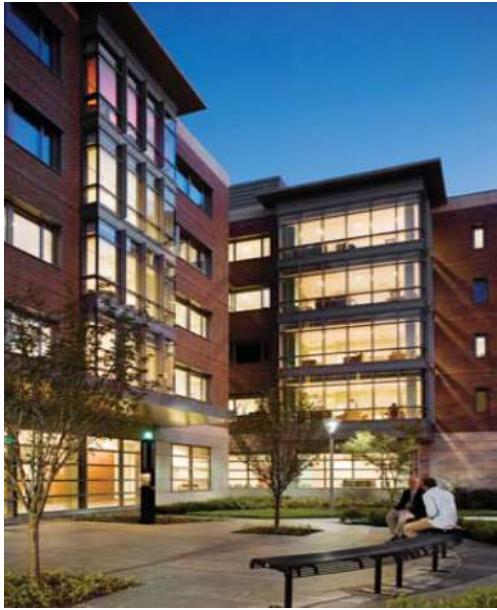
شكل 11. الواجهة الخارجية للمبنى
